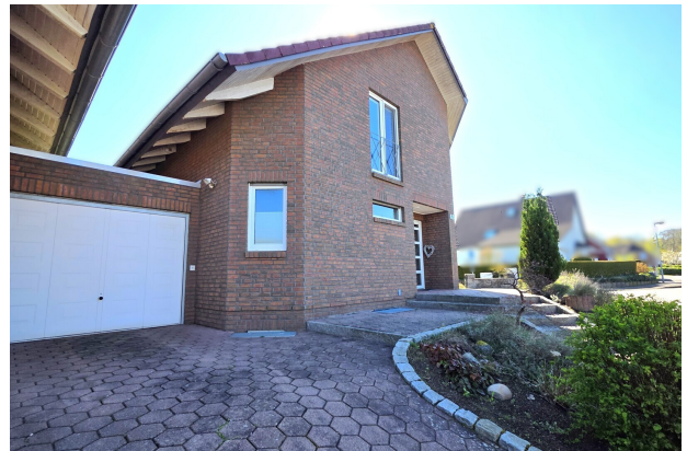
Hausansicht mit Garage
