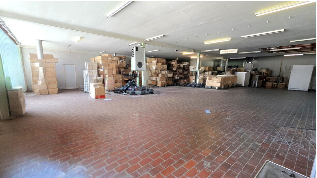
Lagerhalle (ca 409 qm)
