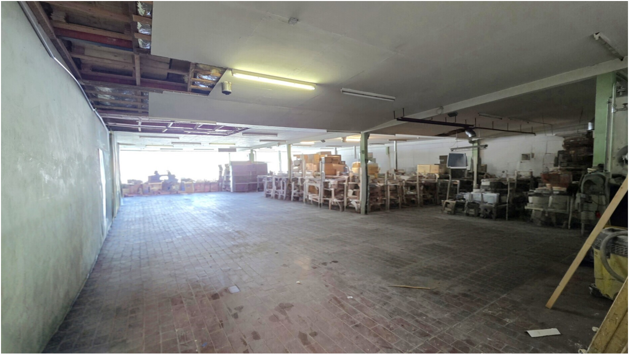
Lagerhalle (ca 409 qm)
